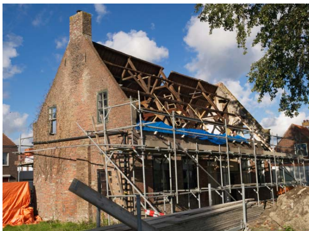
Historisch woonhuis aan Kromwegesingel 18 te Oost-Souburg, tijdens restauratie in 2010. (foto: Rene Olsthoorn, Wikimedia Commons)
